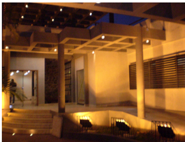
Fachada del nuevo local del Centro de Entrenamiento del Ministerio Público.
