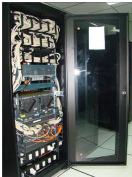
Tendido de cables totalmente de fibra óptica
