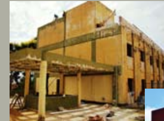
Inicio de obra
